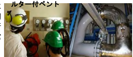
図6 手動耐圧ベントの操作ハンドルと耐
