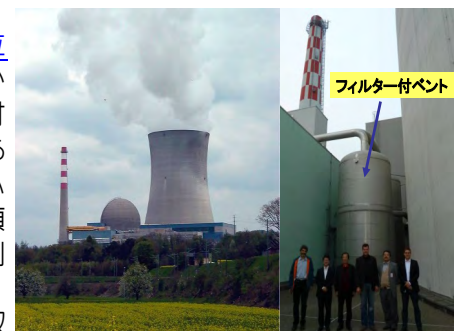
図5 ライブシュタット発電所とフィルター付ベント
