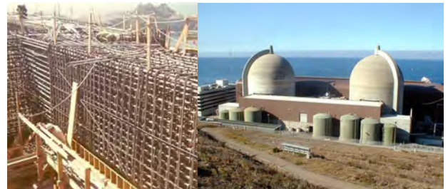
図1. 強固な鉄筋基礎、図2完成した発電所
