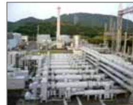
予備変圧器、所内開閉装置を高台へ移設[自主]
