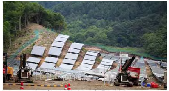
山の斜面に設置する太陽光発電
